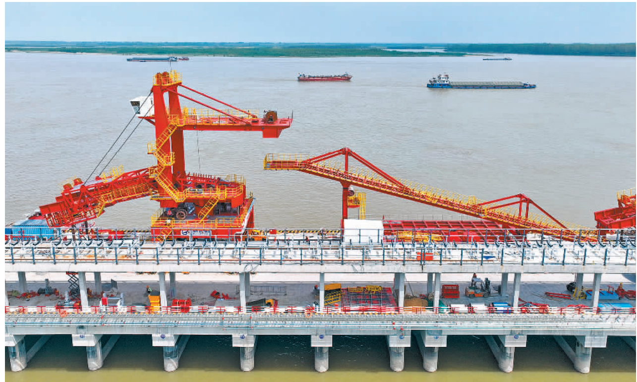
6月13日,江西省九江市红光国际港口银砂湾码头项目正在加快建设。该码头是一座散杂货综合码头,建成后助力九江高标准建设长江经济带重要节点城市。张 玉摄(中经视觉)
