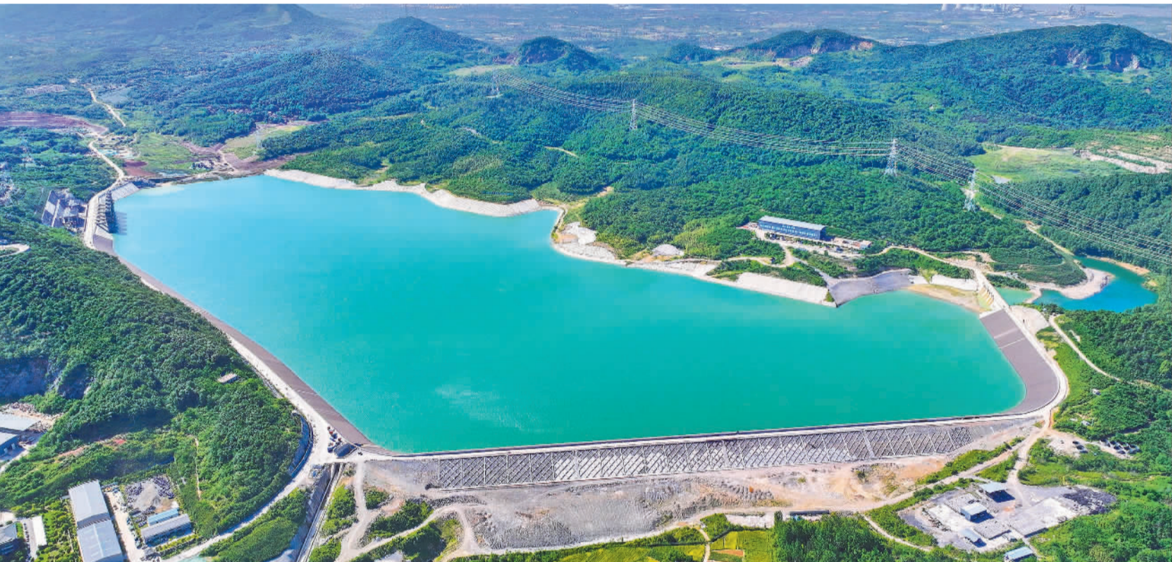
6月6日,江苏句容抽水蓄能电站配套500千伏送出工程建成投运,首台机组将于今年8月并网发电。该电站上水库大坝高达182.3米,年发电量13.5亿千瓦时,可满足约36万户家庭一年的用电,每年可减排二氧化碳、二氧化硫约35.7万吨。 史俊摄(中经视觉)
