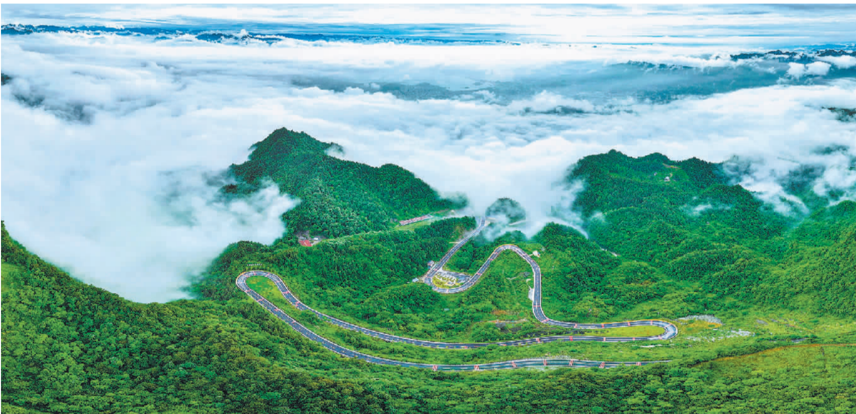
6月5日,地处三峡库区湖北省宜昌市秭归县的山区公路。近年来,当地加大乡村公路的建设和维护力度,让乡村公路成为致富之路。
