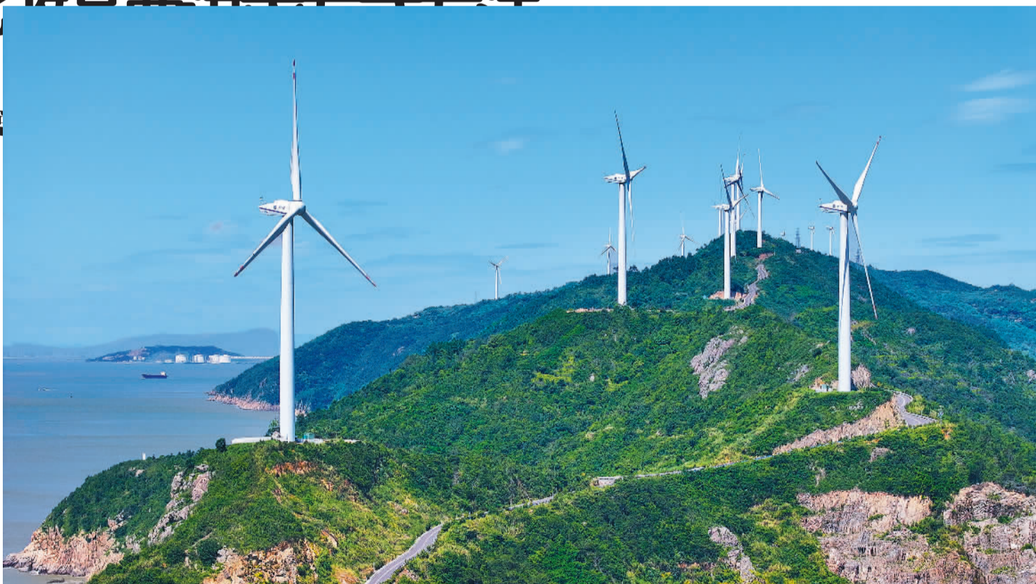
5月28日拍摄的浙江省玉环市大麦屿街道鹭鸶礁山巅风电场。
