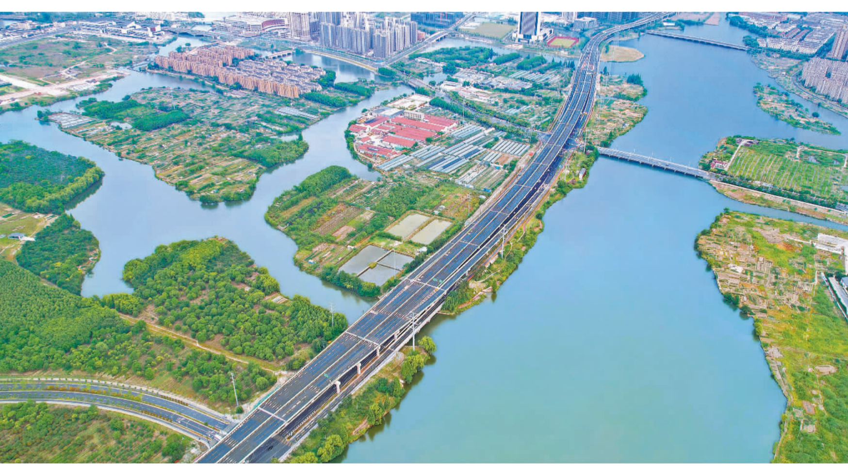
5月26日,由中铁二十二局承建的绍兴绿云路智慧快速路工程I标段(洋江西路—群贤中路段)顺利通车。该快速路是浙江省首个全方位采用绿色建造模式的大型市政道路工程...
