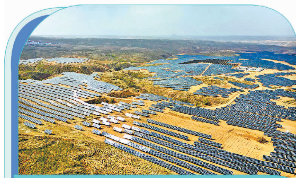
内蒙古鄂尔多斯市伊金霍洛旗推进矿山生态环境治理,对采煤沉陷区内土地进行生态修复,在修复基础上建起天骄绿能50万千瓦光伏发电项目。新华社记者李志鹏摄
