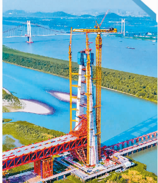
图为徐工集团XGT15000-600S在马鞍山长江大桥施工。 刘 楚 摄
