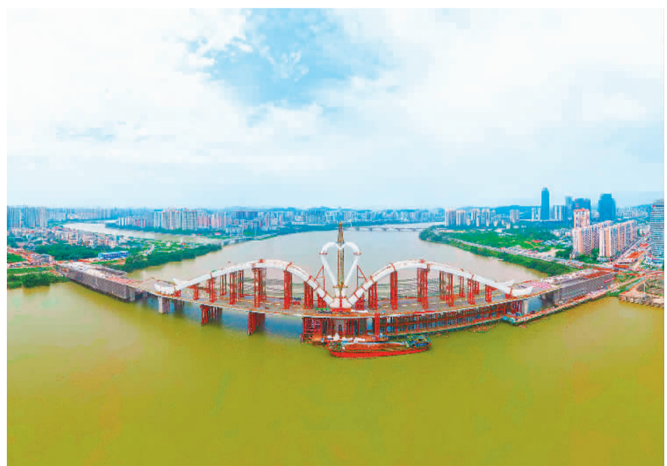
5月13日,广东省惠州市鹅城大桥主桥顺利合龙。鹅城大桥全长1119.5米,采用钢梁钢拱结构,按双向6车道设计,横跨630米东江水域,是惠州中心城区新增过江通道的重大工程。鲍贇生摄(中经视觉)
