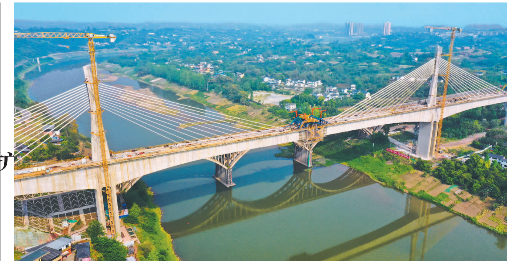
4月15日,四川省泸州市龙马潭区隆黄铁路沱江特大桥项目施工现场,工人正在进行合龙前的冲刺作业。该项目连接龙马潭区胡市镇和江阳区况场街道,建成后有望成为国内最大跨度的铁路单索面斜拉桥。
