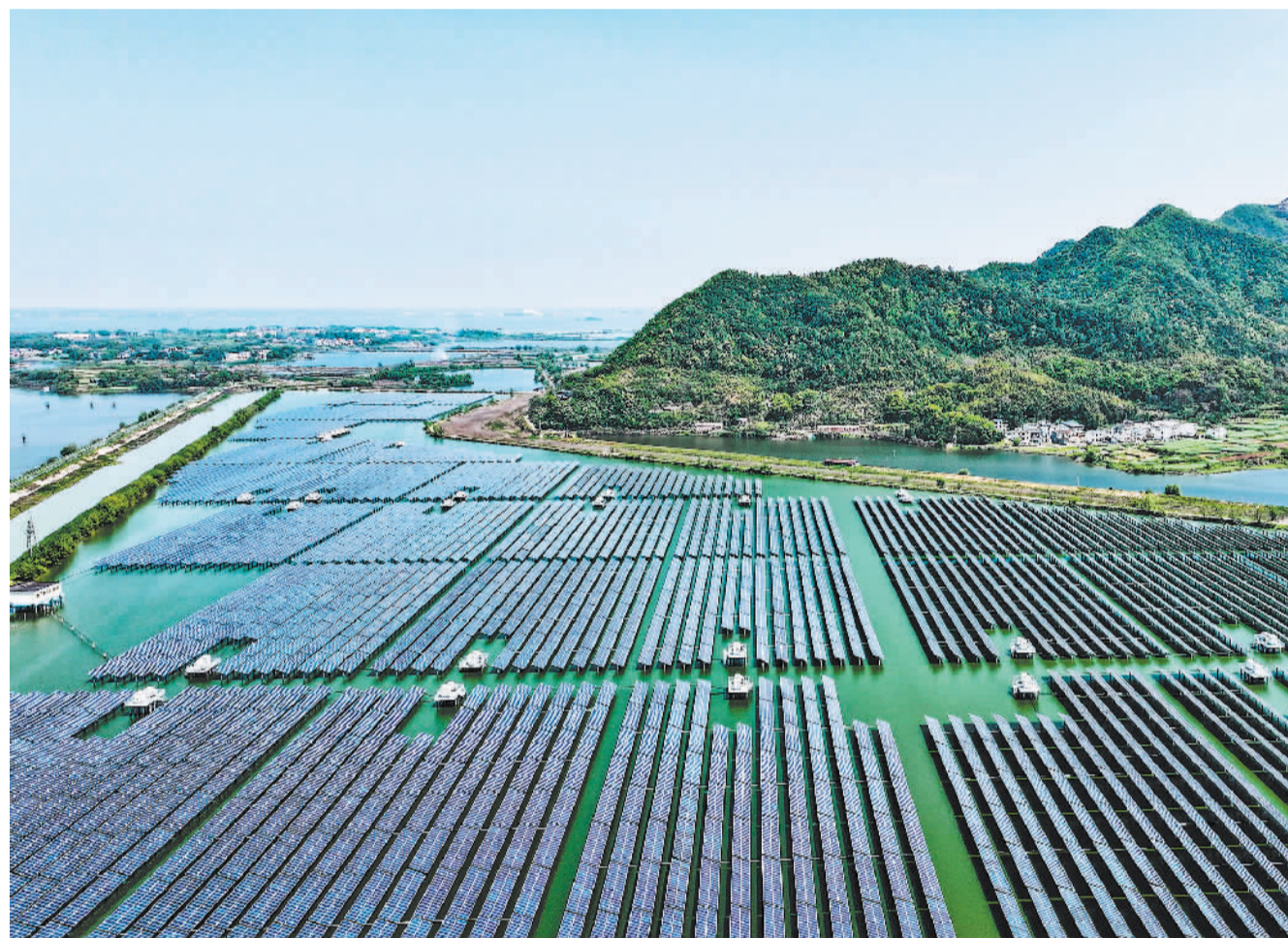
4月9日，江西省瑞昌市武蛟乡达尔湖50兆瓦光伏发电站与周边景致浑然一体。近年来，瑞昌市坚持生态优先、绿色发展，将光伏产业与渔业养殖相结合，充分挖掘资源优势，形成了“水上能发电、水下能养鱼”的局面。魏东升摄(中经视觉)
