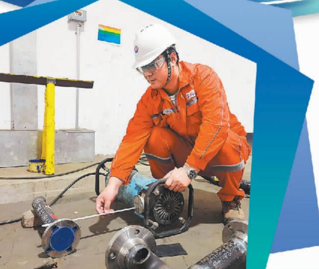
海洋石油工程公司无损检测工程师刘凯在进行射线机焦距测量工作。贾刘仁摄(中经视觉)
