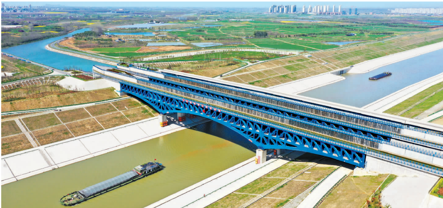
3月30日,货运船只在引江济淮工程安徽省合肥市蜀山区段航道有序航行,驶过引江济淮总干渠钢桁梁渡槽。引江济淮工程是国务院部署加快建设的172项重大节供水工程之一,供水范围涵盖55个区县。陈三虎摄(中经视觉)
