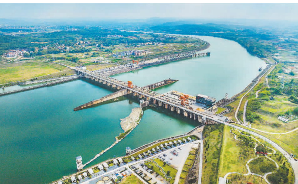
广西郁江老口航运枢纽工程,风景如画。该枢纽工程位于广西南宁市区西约34公里、左右江汇合口下游5公里处的郁江上游,是集航运、防洪、发电、供水等多功能于一体的综合水利枢纽,为促进当地经济社会发展发挥了重要作用。曾祥忠摄(中经视觉)
