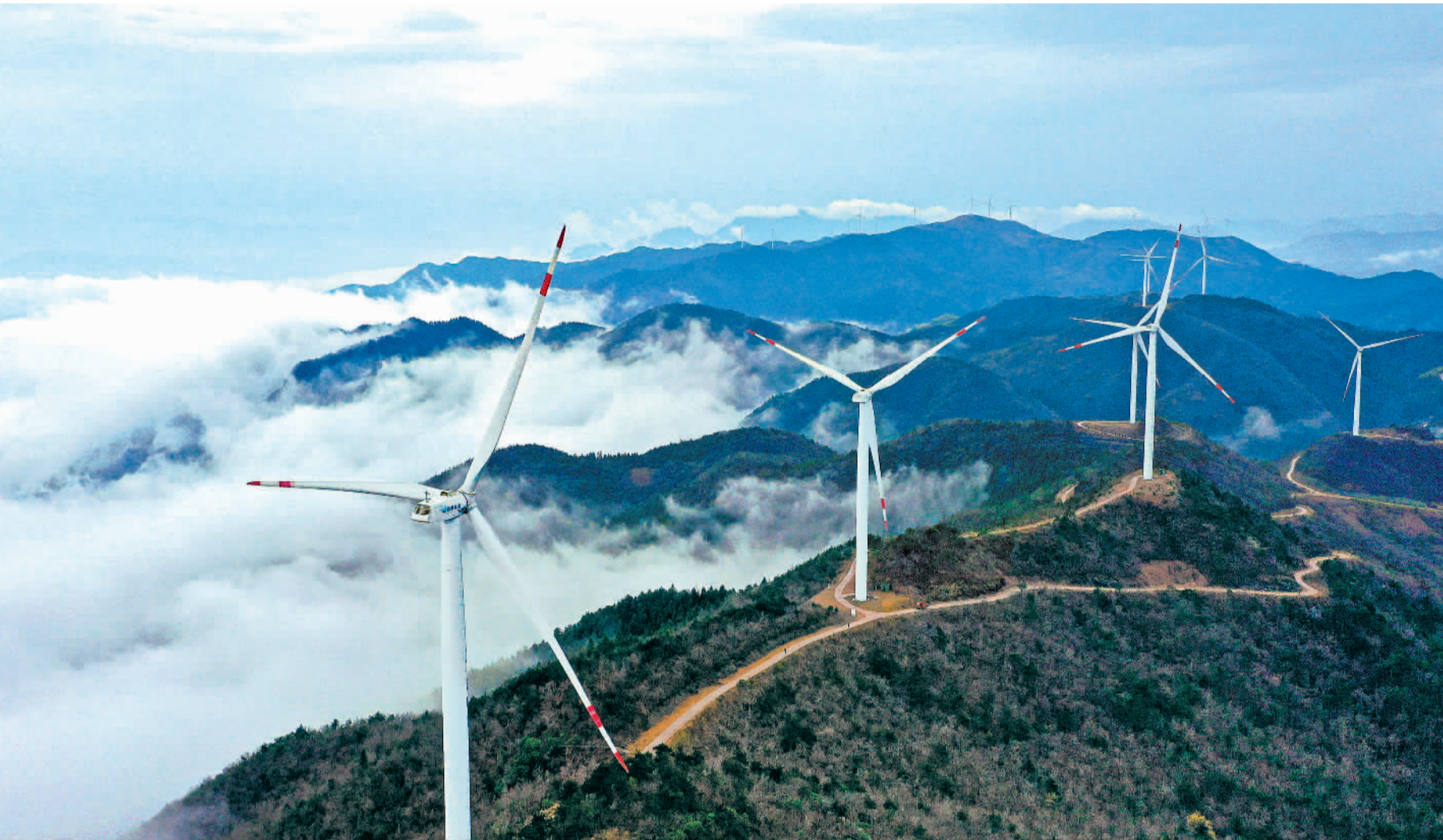
3月24日，浙江省台州市仙居县广度乡风力发电场，一台台风电机组在云雾中起舞，源源不断输送着清洁能源。近年来，当地充分利用高山风力资源，发展清洁能源项目，形成风能开发、观光旅游、生态保护融合发展生态长廊。 王华斌摄(中经视觉)
