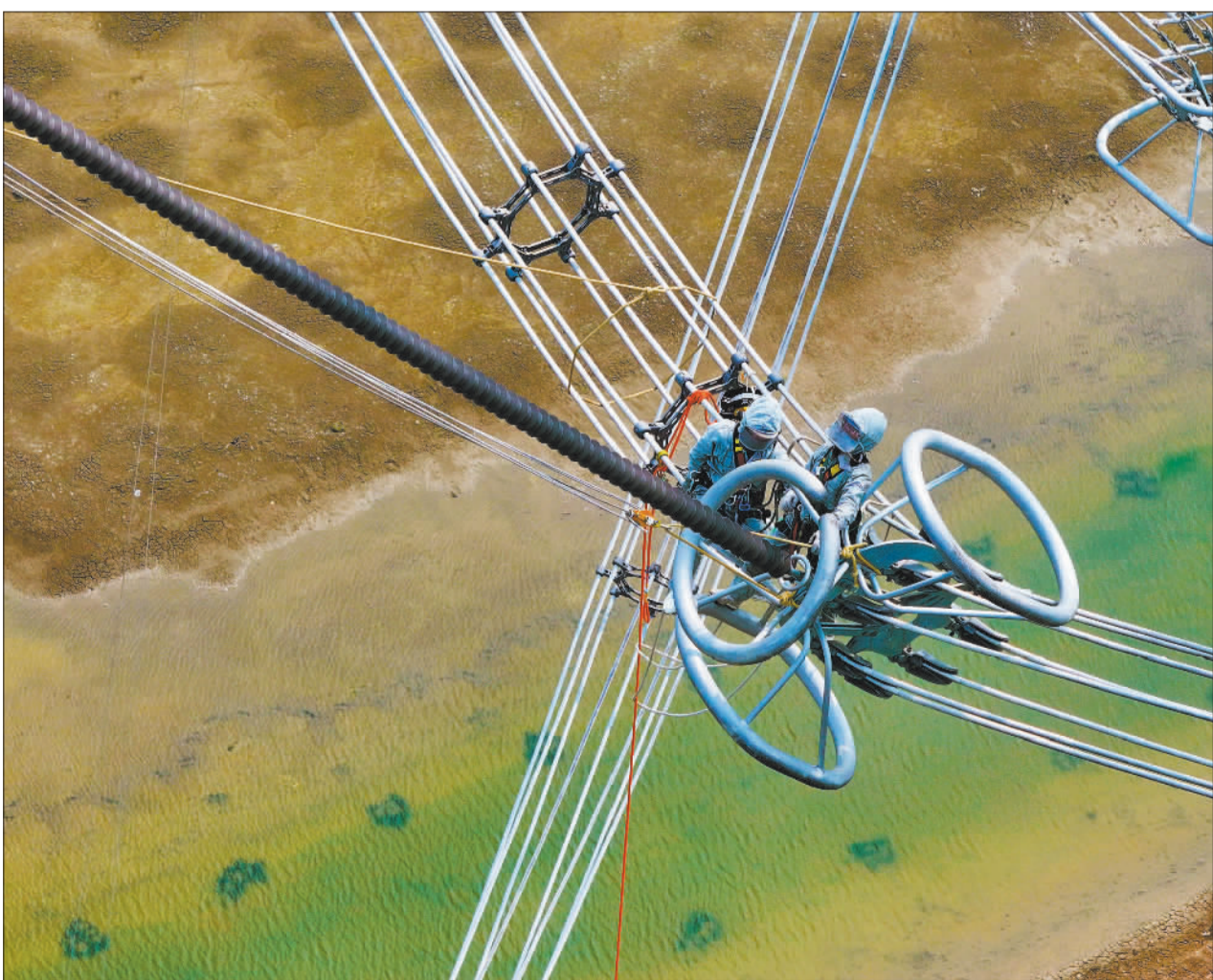
▼江苏省金湖县金南镇,国网江苏电力技术人员在特高压换位塔更换跳线绝缘子串。该公司填补了我国带电更换百万伏特高压换位塔电气设备的技术空白。 梁德兵摄(中经视觉)
