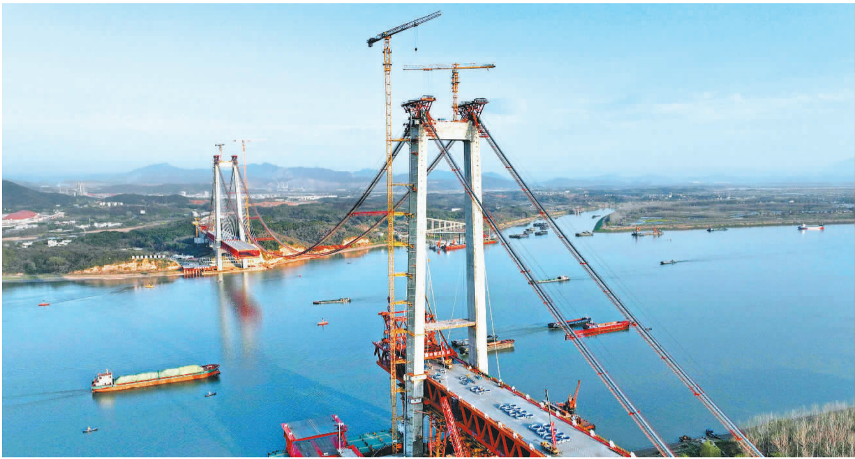
3月21日,中铁大桥局采用单悬臂法顺利完成G3(京台高速)铜陵长江公铁大桥北岸首节1200吨中跨钢梁架设,标志着大桥全面进入主跨钢梁施工阶段,预计今年7月份完成合龙。大桥建成后,对加强长三角地区互联互通具有重要意义。
