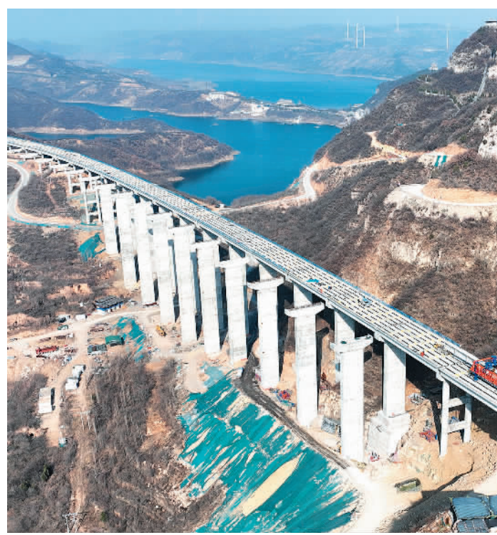
3月11日,位于河南省济源市的济新高速公路黄河桃花岛大桥左幅顺利贯通。济源至新安高速公路建成后,将进一步完善豫晋高速公路网。段二平摄(中经视觉)
