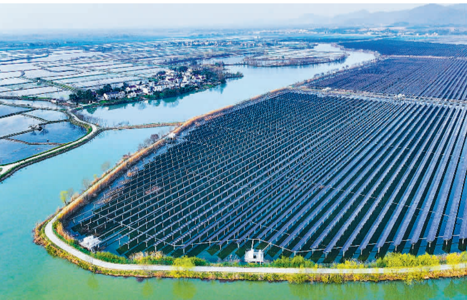
安徽省芜湖市繁昌区平铺镇的岱湖滩“渔光互补”光伏发电基地，连片的光伏发电板与周边的稻田、民居、沟渠等相映成趣。近年来，当地坚持生态优先、绿色发展理念，将光伏产业与渔业养殖相结合，“水上能发电、水下能养鱼”，实现经济、生态效益双丰收。 鲁君元摄(中经视觉)
