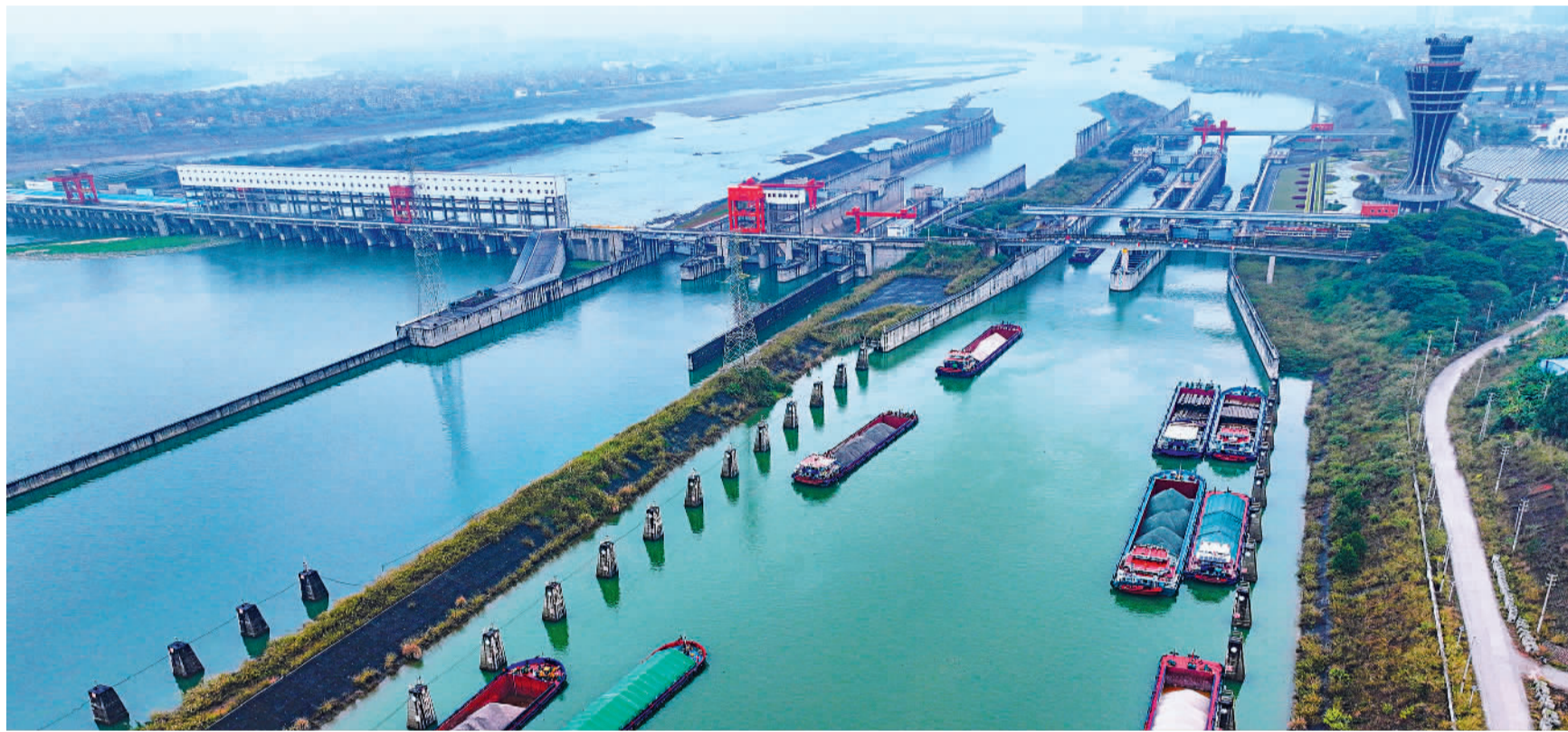
3月9日，广西梧州市长洲水利枢纽，各类满载货物的船只正在有序待闸通过。长洲水利枢纽是西江航运干线最后一个梯级枢纽、西江黄金水道的“咽喉”，以发电和航运为主，兼有防洪灌溉、淡水养殖、供水、旅游等综合利用功能。
