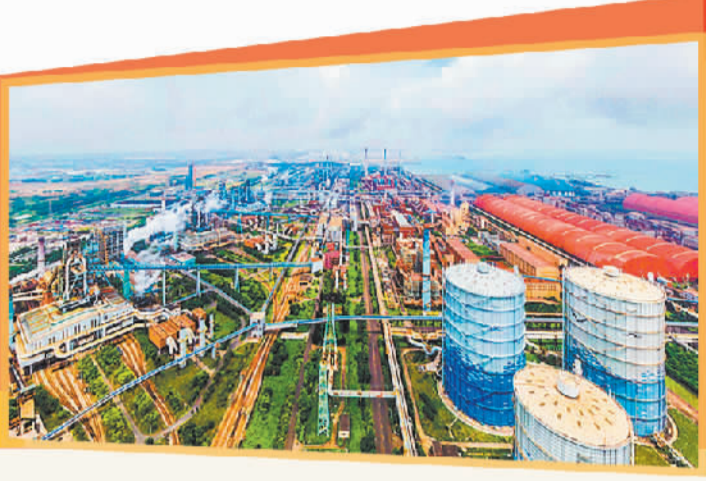
上图 位于广东省湛江市的宝钢湛江钢铁厂区。 新华社记者 邓华摄 左图 我国首艘由国内船企建造的汽车运输船装载着新能源汽车从山东港口烟台港起航。 唐克摄(中经视觉)
