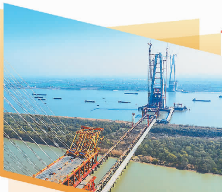
安徽巢马城际铁路马鞍山长江公铁大桥主汉航道桥建设现场繁忙有序。 张明伟摄(中经视觉)
