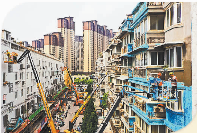
安徽省芜湖市镜湖区天置山庄小区，施工人员进行老旧小区进行改造。 陈效宝摄 (中经视觉)
