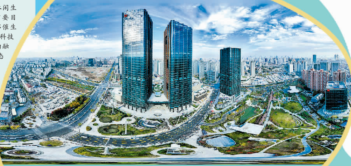
上海市普陀区海纳小镇数字化转型示范区全景。
