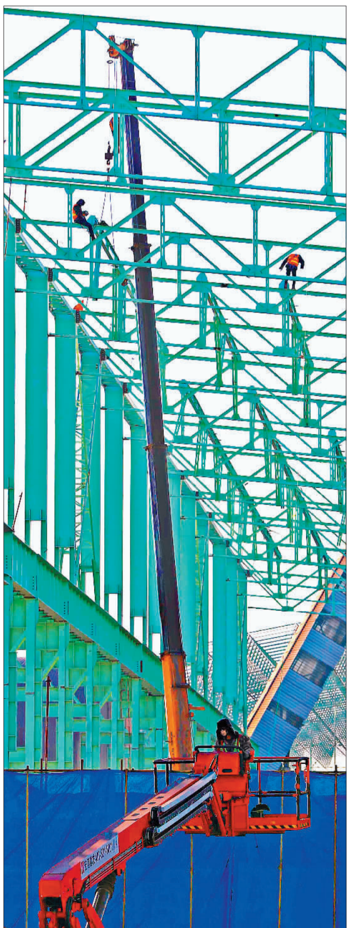
◀2月17日,内蒙古兴安盟敬业集团乌兰浩特钢铁有限公司双高棒技改工程现场,建设者在安装屋面檩条。 郑志宏摄(中经视觉)
