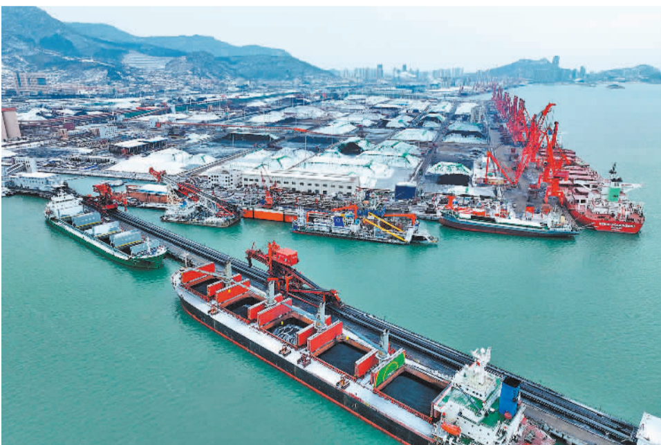
2月2日，江苏连云港港煤炭码头，货轮正在卸载电煤。寒潮来袭，该港启动电煤运输“绿色通道”，24小时不间断作业，提高电煤卸载和转运速度，满足发电企业用煤需求，保障电力供应。 王春摄(中经视觉)
