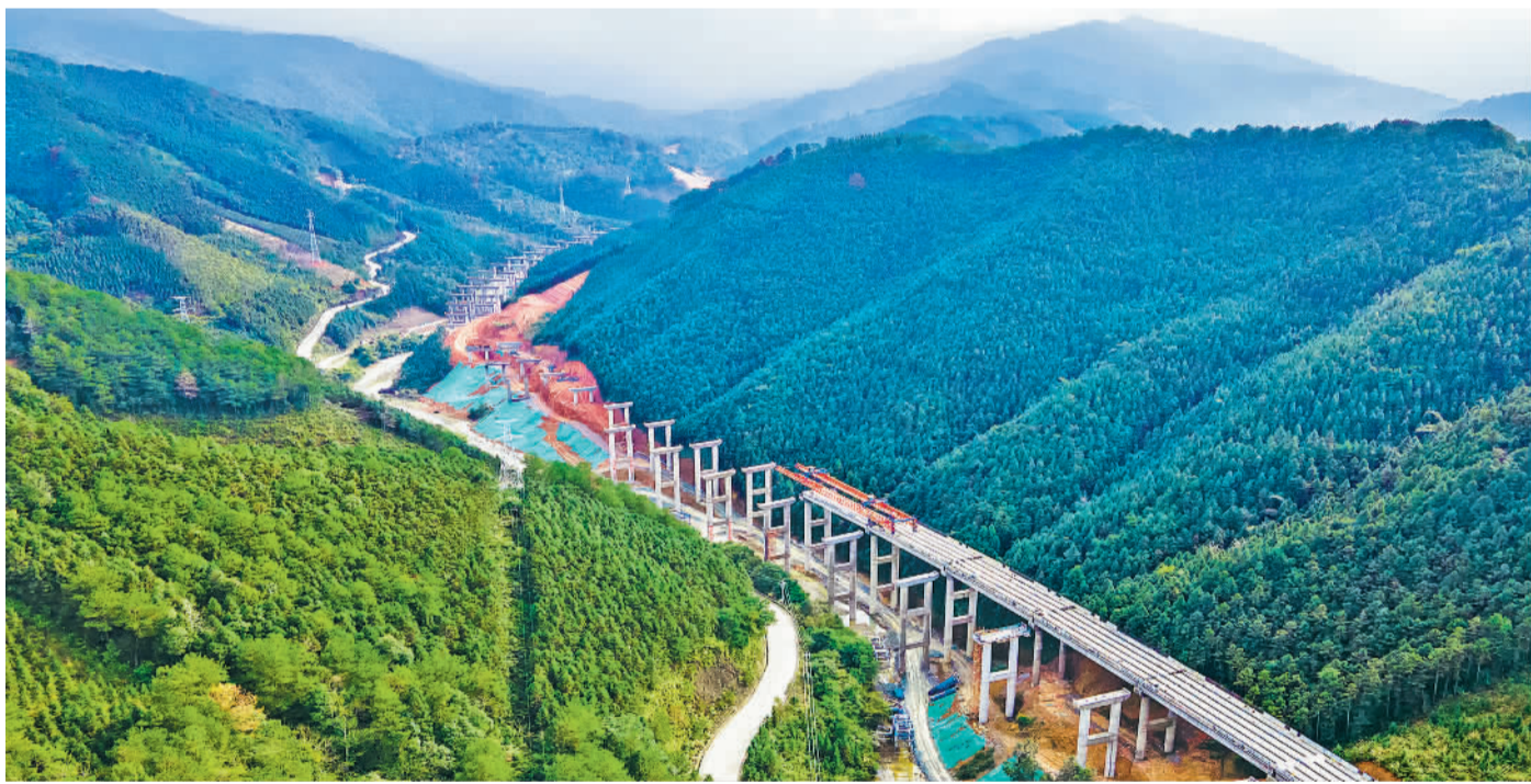
2月1日，在广东清远连山至广西贺州高速公路（广西段）公罗口特大桥项目建设现场，梁板架设施工作业正加紧进行。该项目建成后将进一步完善广西高速公路网络，促进区域间交通互联互通。 黎蒙摄（中经视觉）
