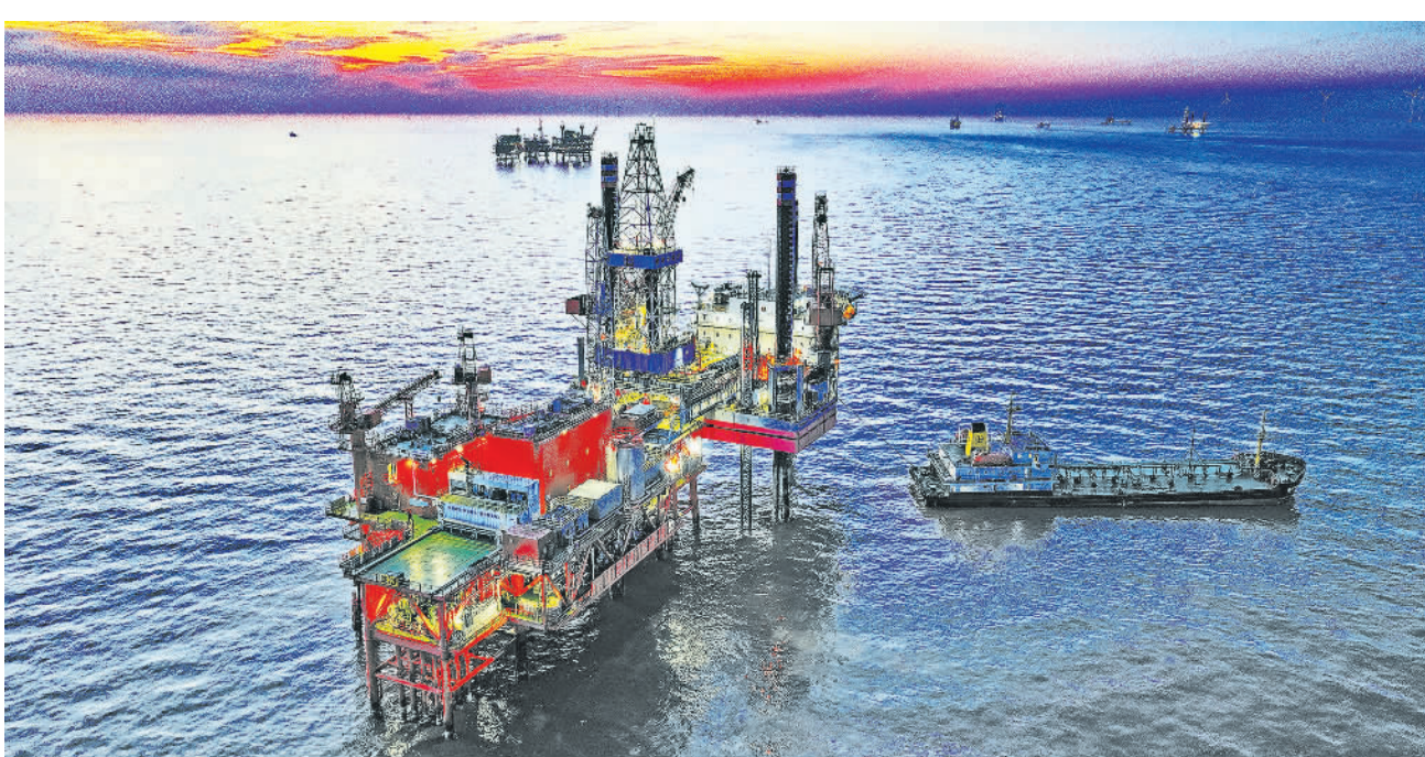
1月28日,胜利作业六号平台正在对北22FC-平3注聚受效并进行检维修作业。近年来,中国石化胜利油田加强海上开发技术创新,提升区块整体注聚效果。截至目前,化学驱中心油井全部受效,增油效果明显,含水率下降显著。张 灿摄(中经视觉)
