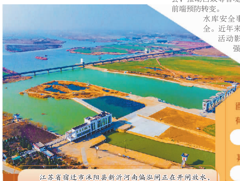
江苏省宿迁市沐阳县新沂河南偏泓闸正在开闸放水，保障下游小麦冬灌。张连华摄（中经视觉）
