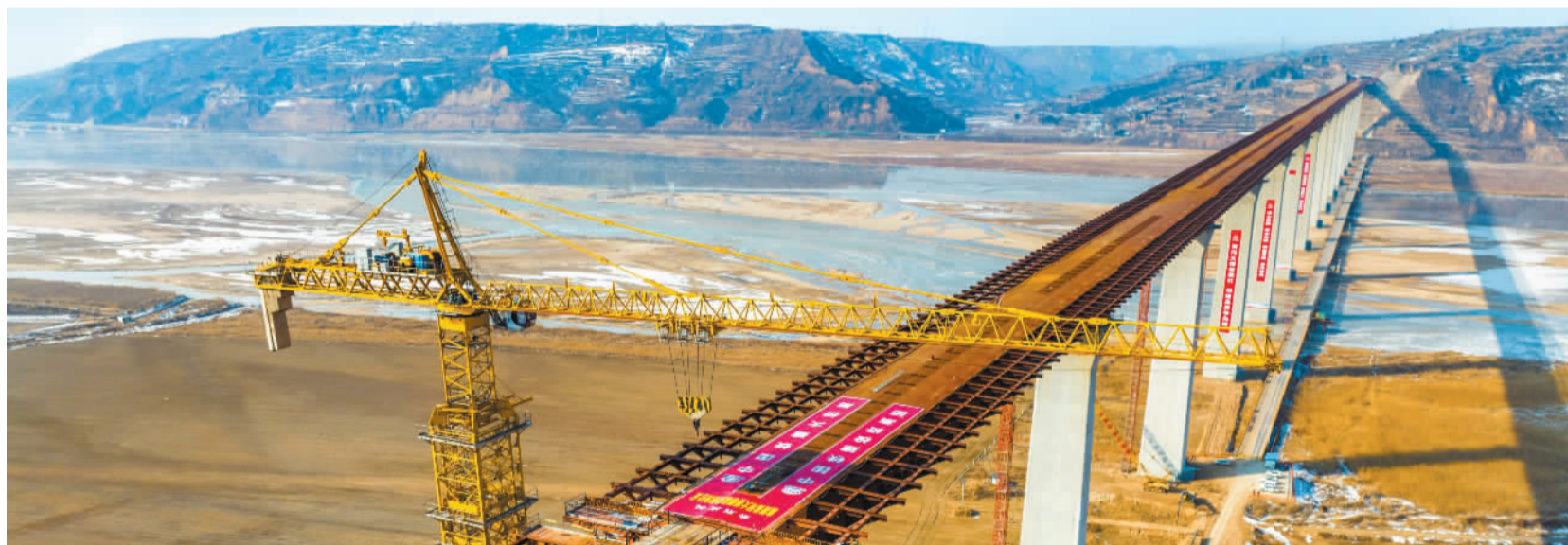
1月26日,随着最后一跨钢箱梁顶推到位,山西省运城临猗黄河大桥主桥钢箱梁顺利合龙,为今年通车运营打下了基础。项目建成后,将使运城至陕西铜川通车时间由4小时缩短至2.5小时。薛俊摄(中经视觉)
