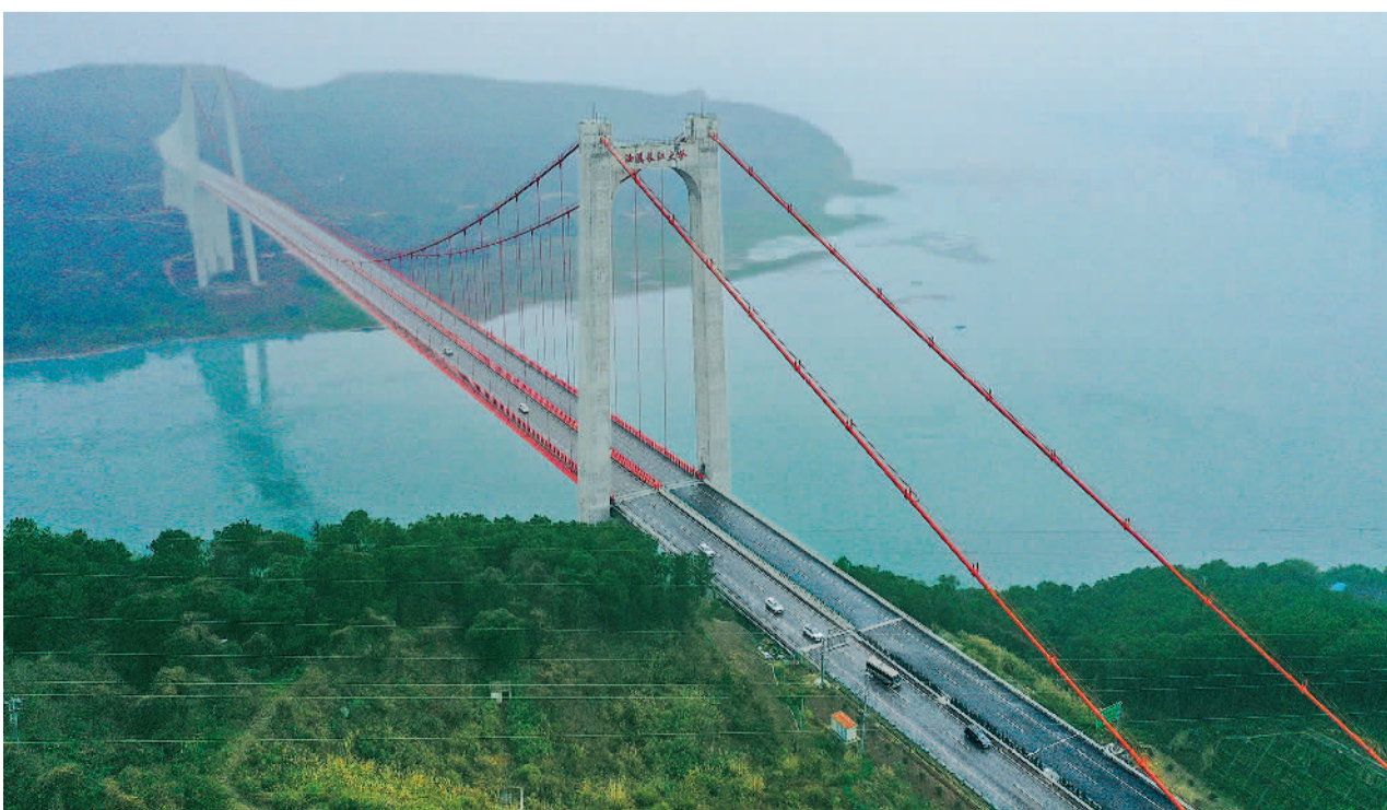
1月26日，车辆行驶在合璧津高速江津段油溪长江大桥。当日，由中铁建重庆投资集团投建的合璧津高速江津段正式建成通车。合璧津高速江津段起于重庆市江津区油溪枢纽，通达至慈云北枢纽，全长约15公里。 新华社记者 王全超摄
