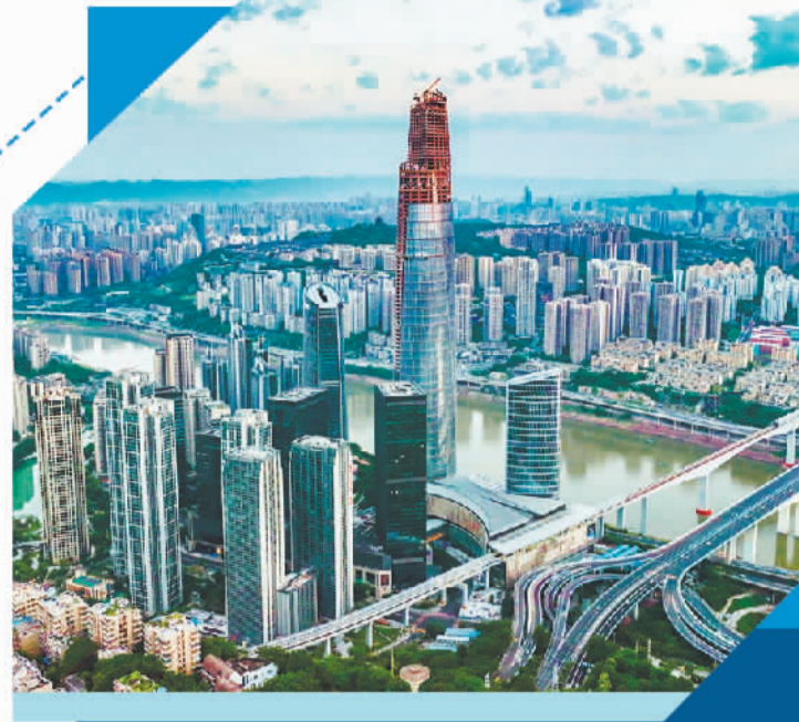
由中建三局三公司承建的重庆陆海国际中心。王凯伦摄(中经视觉)
