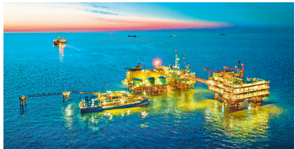
1月25日，亚洲首座油气处理与岸电设备共建平台——埕北油田CEPC（中心平台）在渤海油田成功投产。该平台首创油气生产与岸电供应共建新模式，为我国海洋油气资源高质量开发打造了绿色新样板。杜鹏摄（中经视觉）
