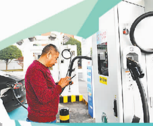
近日,湖南省首个集“光伏+储能系统+液冷超充+车辆检测”功能于一体的充电站正式投入使用。 新华社记者 陈振海摄
