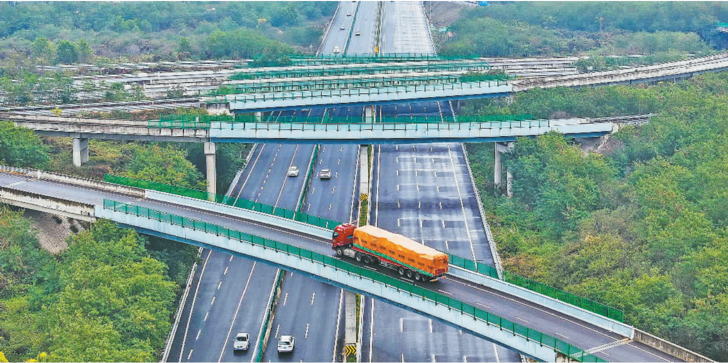
1月23日拍摄的沈海国家高速茂港段竹园互通立交。茂港段改扩建工程接近尾声。该项目位于衢州半岛,全长约108.6公里。车道扩建后,将大幅提升通行能力,促进粤西地区与珠三角串联互通,更好发挥粤港澳大湾区辐射作用。
