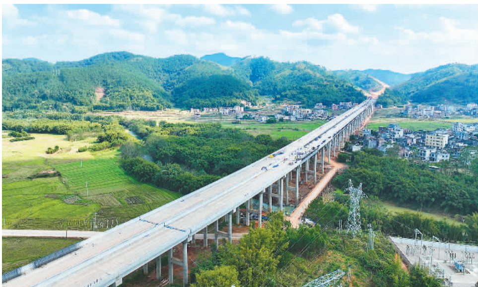
1月18日，广西岑溪市三堡镇扶南村，广西柳州—平南—岑溪高速（平南至岑溪北段）公路义昌江特大桥建设现场一派繁忙景象。岑溪高速公路建成后，将进一步满足当地群众日益增长的交通出行需求，推动经济社会高质量发展。 林志清摄（中经视觉）
