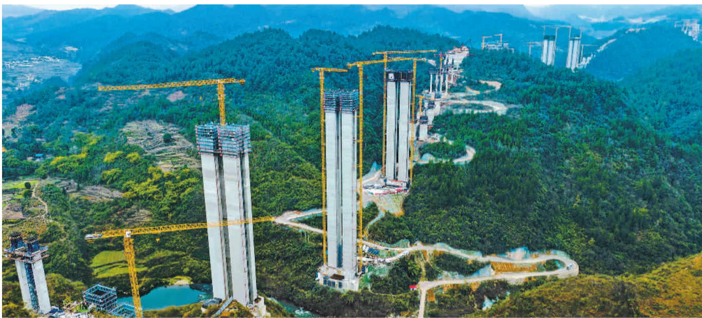
1月20日，贵州公路集团承建的贵平高速公路南明河特大桥主墩顺利封顶。贵(阳)平(塘)高速公路为《国家公路网规划》贵阳至北海高速公路重要路段，是西部陆海走廊重要组成部分，也是贵阳至南宁最便捷通道。高速公路建成通车后，将有效带动沿线经济社会发展。邓刚摄(中经视觉)
