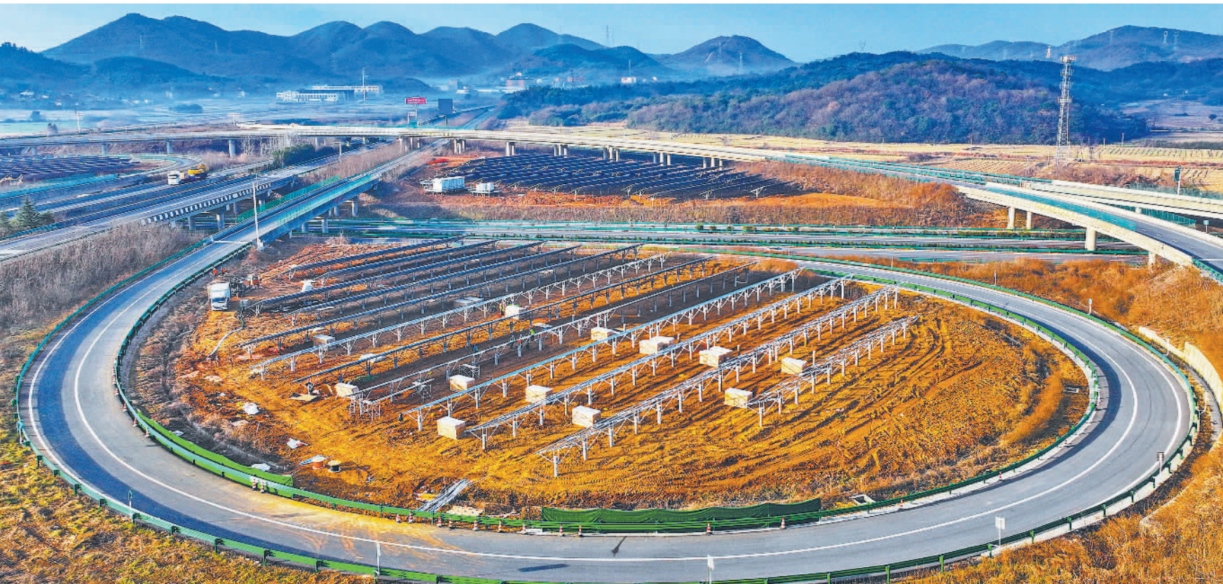
1月14日,安徽省芜湖市繁昌区东枢纽2.76MWp光伏发电项目现场,施工人员正全力推进项目建设。近年来,当地坚持生态优先、绿色发展理念,聚焦绿色低碳转型发展,大力发展光伏发电等绿色清洁能源项目。
