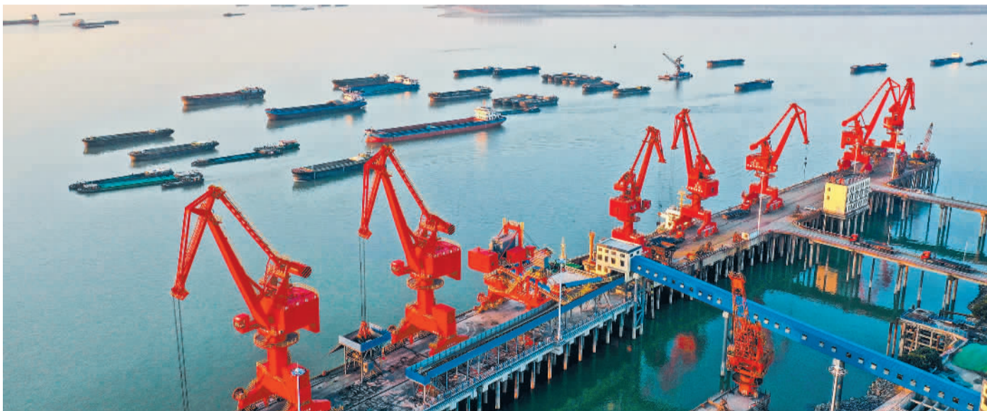
1月13日拍摄的安徽铜陵长江兴港码头,港口机械在装卸物资。铜陵长江兴港码头、金城码头改扩建工程近日相继交工验收,铜陵港万吨级泊位由3个提升至6个,新增630万吨吞吐能力。 过仕宁摄(中经视觉)
