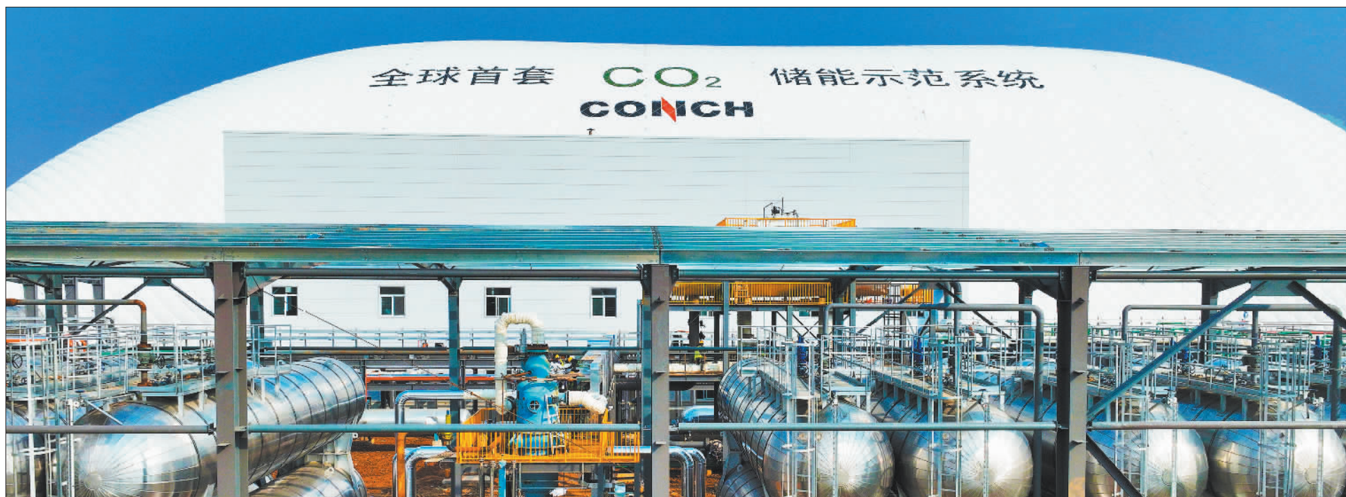
▼1月9日,安徽芜湖,10MW/80MWh二氧化碳储能示范系统项目正在并网试验。 王玉实摄(中经视觉)
