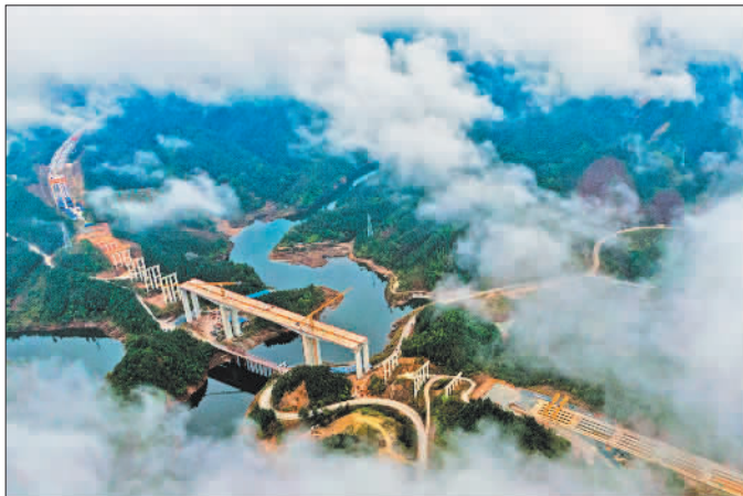
▲1月9日,广西柳州,融从高速公路一期工程正在建设中。 龙涛摄(中经视觉)
