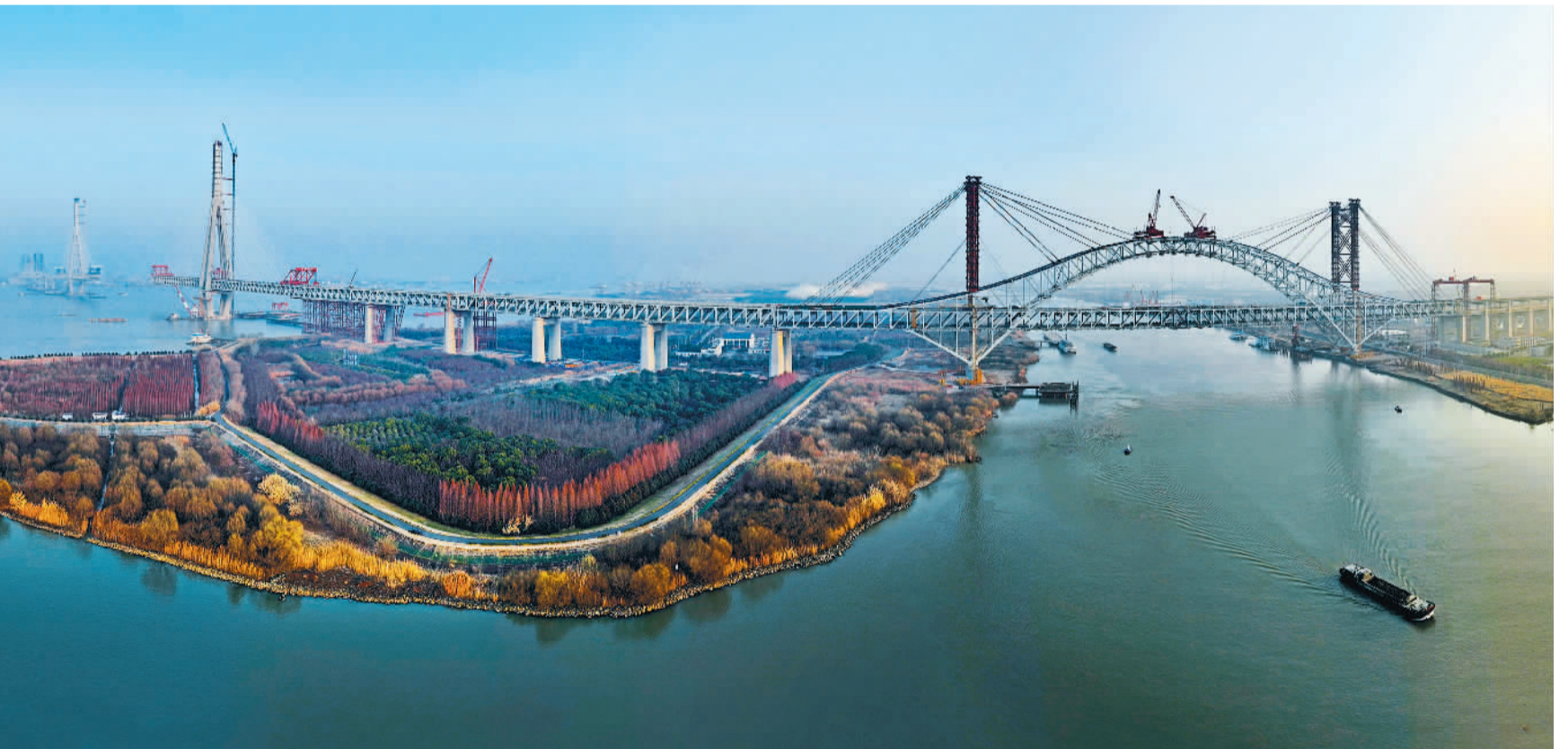
1月12日,位于江苏省常州市的常泰长江大桥安洲专用航道桥顺利合龙。至此,常泰长江大桥除了主航道桥以外,其余部分均已建成。大桥连接江苏省的常州市与泰州市,是一座集高速公路、城际铁路、普通公路于一体的过江通道。
