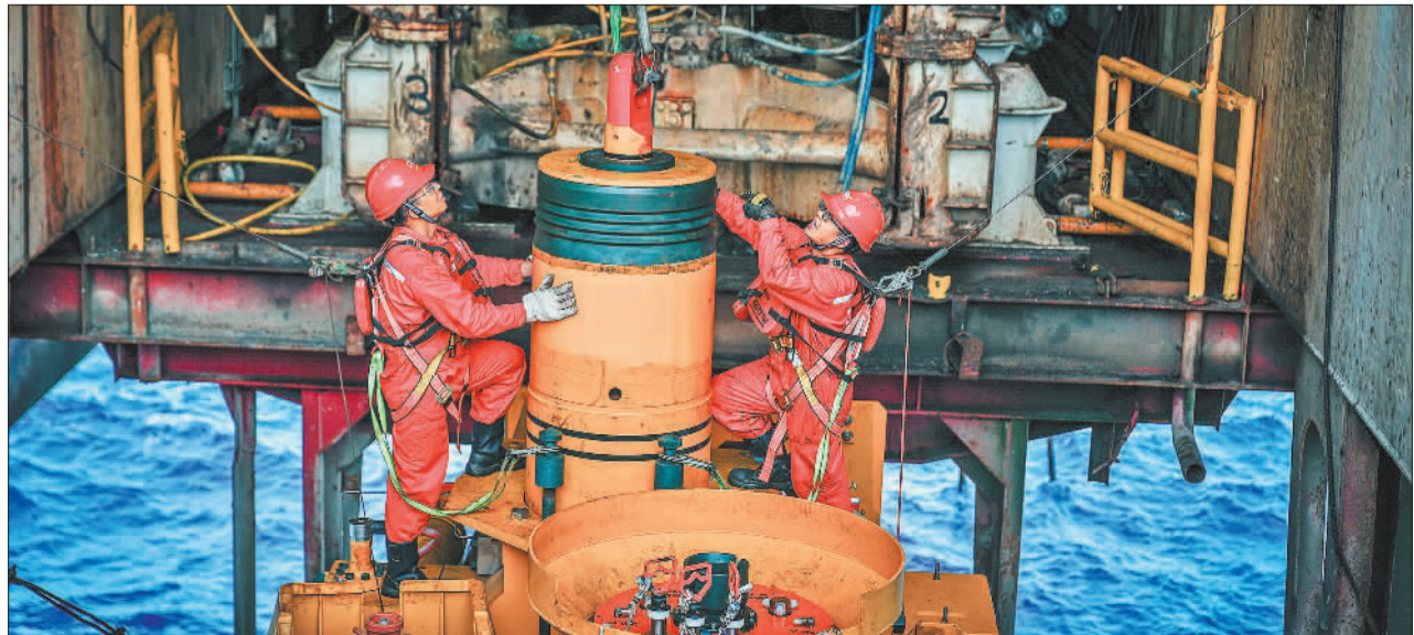
▼国产采油树在月池就位后,工程师正在对其进行下水安装前最后环节的检查。这是我国首套国产化深水水下采油树设备首次安装,标志着我国深水油气开发关键技术装备研制迈出关键一步。
