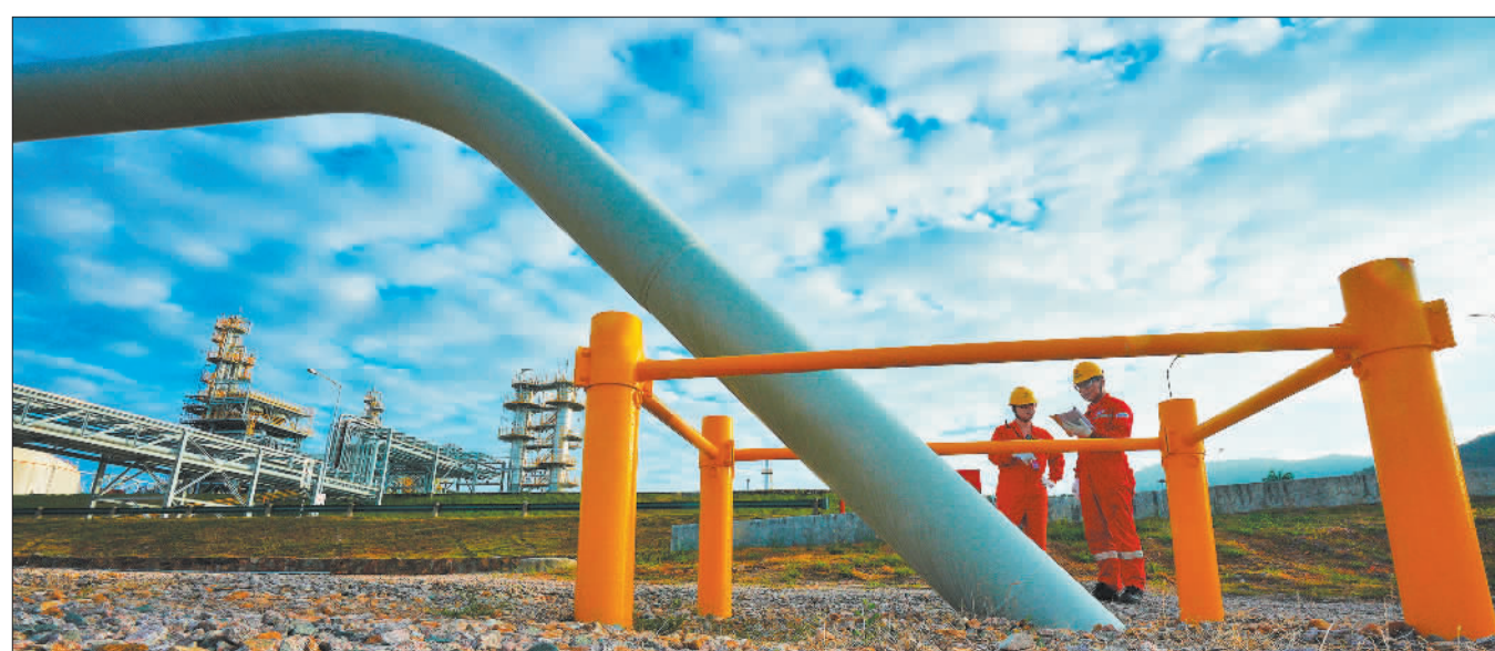
▼在海南三亚中国海油南山终端,操作员检查海底管线上岸段。这是深海与陆地厂区的连接管线,传输回的油气经过厂区处理合格后,为海南自贸港建设提供清洁能源。
