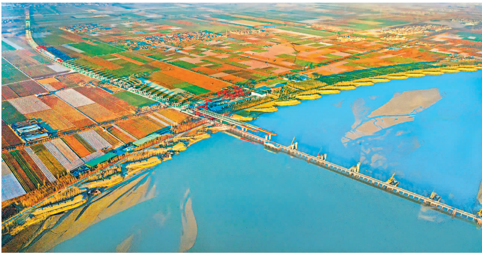
1月3日,河南省重点工程沁伊高速孟州黄河特大桥项目施工现场,工作人员正争分夺秒抢抓施工,确保工程如期完工。 沁伊高速是河南省“十四五”规划重点项目。黄河特大桥为该项目的关键控制性节点工程,长度7.28公里,目前主桥全部桩基施工任务已完成。 白水拍摄(中经视觉)
