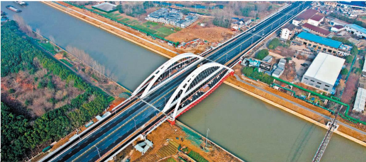
1月1日，由中铁二十局承建的江苏省溧阳市昆仑桥建成通车。该桥是芜申线溧阳城区段航道整治工程中最大的钢结构桥梁，采用全新工艺，10个月完成全部施工，创造了同等规模内河钢结构桥梁的最快施工进度。
