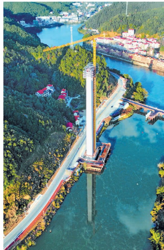
12月30日，江西在建桥梁第一高墩——上犹江特大桥主墩顺利封顶，桥墩高达126米。上犹江特大桥是遂大高速全线控制性和重难点工程，全长1419米，共7联24跨。李建平摄（中经视觉）
