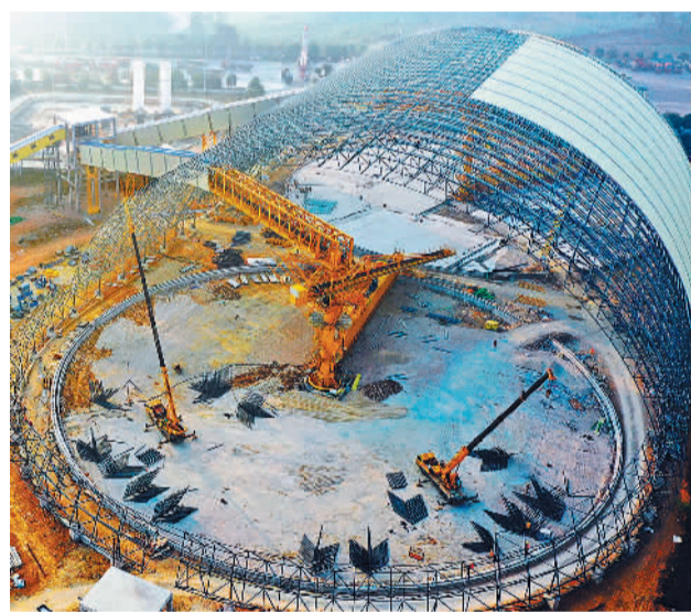
12月27日，在位于广西中国—东盟青年产业园的广西南国铜业有限公司内，工人在安装作业。2023年以来，广西崇左市持续统筹推进产业园区基础设施建设，深化产业园区改革发展，加大要素保障力度，确保一批重大项目如期顺利开工。
