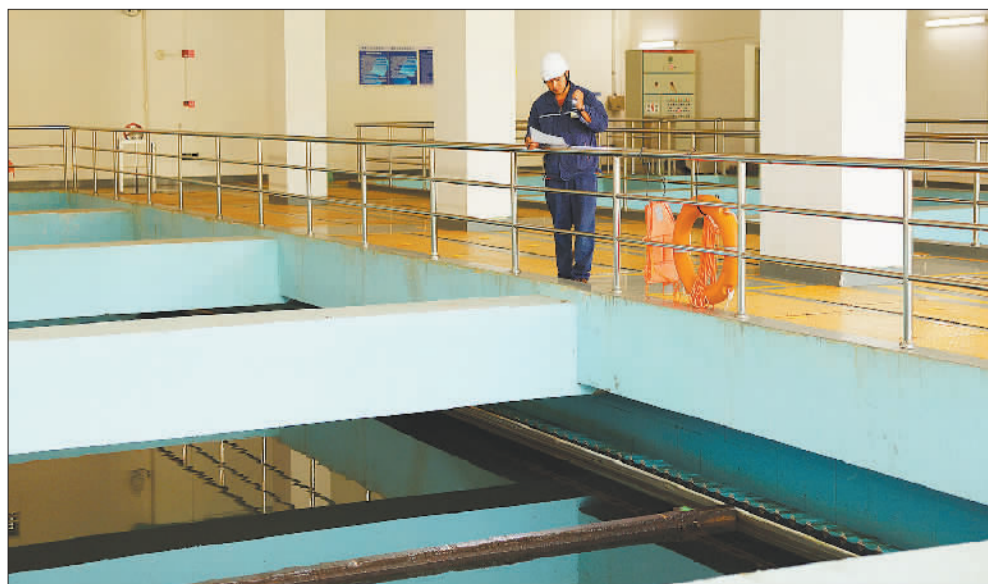
▼大理湾桥下沉式再生水厂采用分布式下沉再生水生态系统，实现生活污水全收集、就近处理后清澈水再流向洱海。
