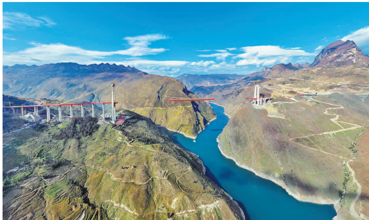
12月13日,由贵州公路集团承建的贵州纳(雍)晴(隆)高速祥野江大桥进入施工关键阶段。目前,大桥已完成73个节段中的30个节段吊装,整体施工进度达94%,预计明年7月完工。 尚宇杰摄(中经视觉)
