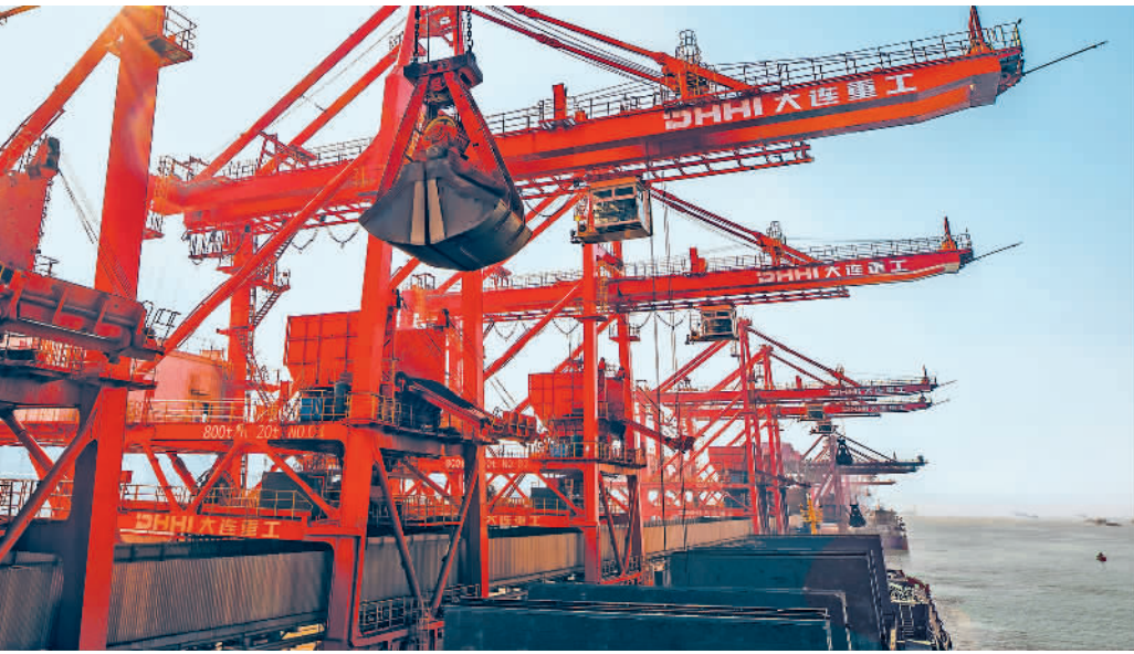
12月5日,位于长江安徽马鞍山水域的中国宝武马钢港务原料码头,起重设备正在装卸生产原料。今年以来,该码头通过实施廊道建设、雨污水系统升级改造等项目,发挥沿江岸线接卸高效率优势,满足江海轮大型船只靠泊,实现绿色低碳运输。
