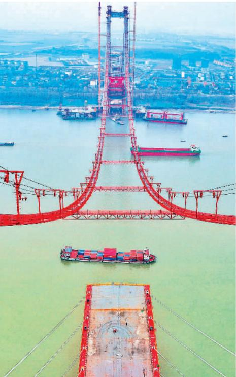
12月4日，京台高速铜陵长江公铁大桥首根主缆索股架设完成，大桥正式进入主缆架设施工阶段。该大桥全长11.88公里，主跨988米，具有高速公路、城际铁路和货运铁路过江功能。詹俊摄(中经视觉)
