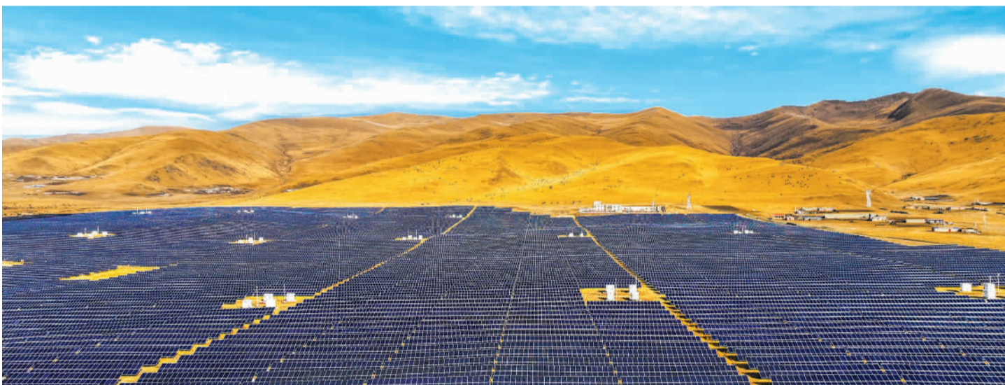
12月1日，在四川省阿坝藏族羌族自治州阿坝县兰措玛光伏电站拍摄的光伏板。近年来，阿坝县立足清洁能源禀赋，积极推进光伏开发，目前全县光伏发电总装机规模已达3.1万千瓦。 严易程摄（中经视觉）
